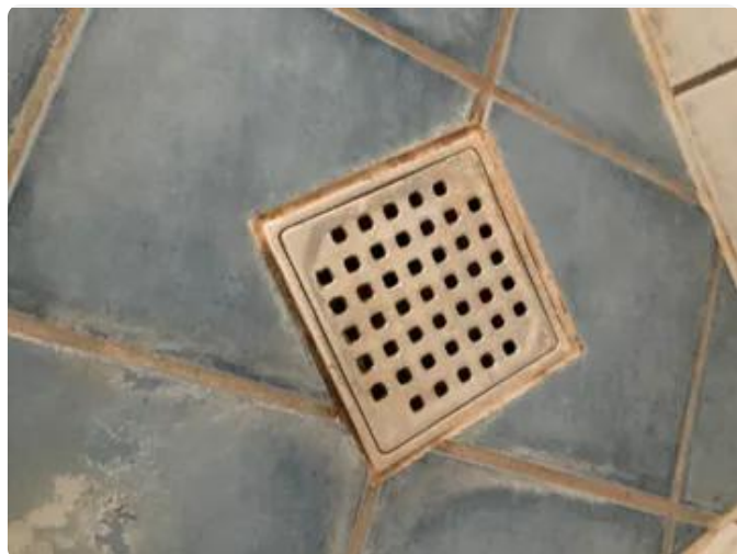
Fuger renses i hus 18
